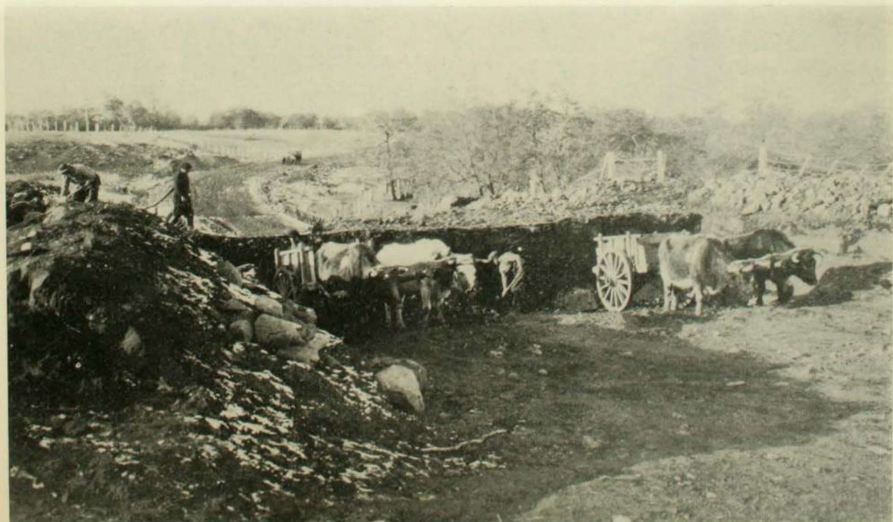
Faena de construcción caminera en el sector de Río Tranquilo (marzo de 1930).
